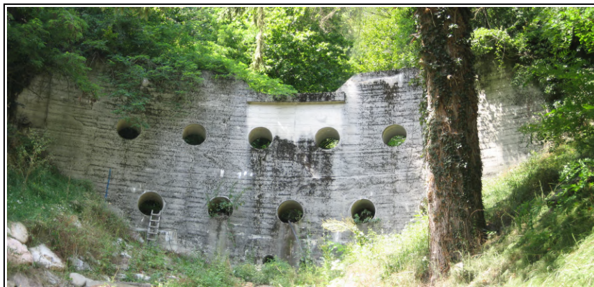
Foto 6.1.2 – Briglia con fori posta a quota 830 m s.l.m..
