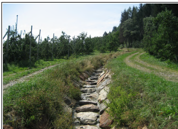
Foto 6.1.5 e 6.1.6 – Tratto di cunettone in massi a sezione trapezia, subito a monte dell'attraversamento della strada comunale per la Val Maora e subito a valle.
