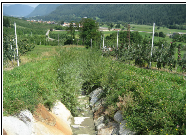
Foto 6.1.5 e 6.1.6 – Tratto di cunettone in massi a sezione trapezia, subito a monte dell'attraversamento della strada comunale per la Val Maora e subito a valle.
