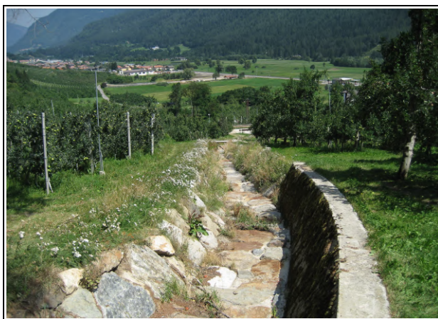
Foto 6.1.3 e 6.1.4 – Tratto di cunettone in massi a sezione trapezia, subito a valle dell'attraversamento di quota 795 m s.l.m. con a lato della strada in forte pendenza con direzione del centro storico di Monclassico e tratto in curva dove l'argine in destra idrografica è realizzato in cemento armato.
