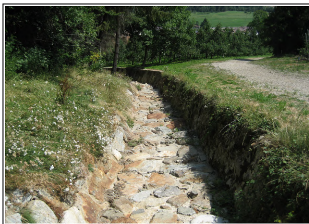
Foto 6.1.3 e 6.1.4 – Tratto di cunettone in massi a sezione trapezia, subito a valle dell'attraversamento di quota 795 m s.l.m. con a lato della strada in forte pendenza con direzione del centro storico di Monclassico e tratto in curva dove l'argine in destra idrografica è realizzato in cemento armato.
